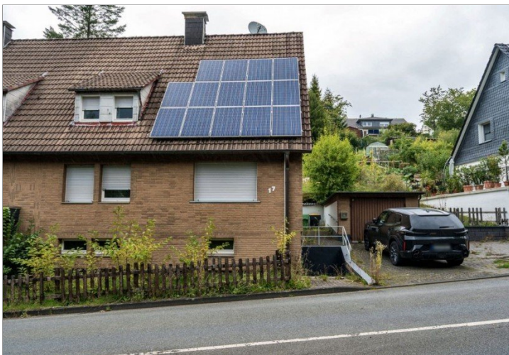
02 Strassenfront mit Photovoltaik
