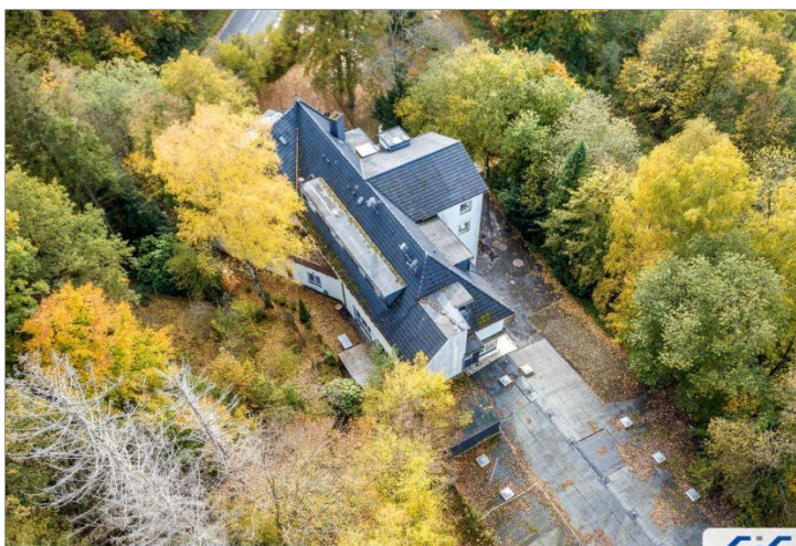
08 Hauptgebäude mit Flachdach Anbau
