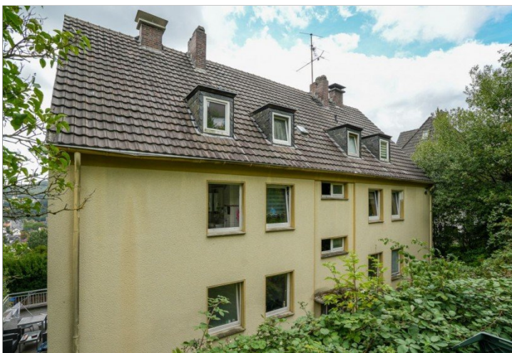
04 Rueckansicht Dach DSC02141
