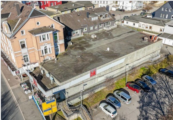
02 Luftaufnahme Ecklage Strassenfront Parkplatz
